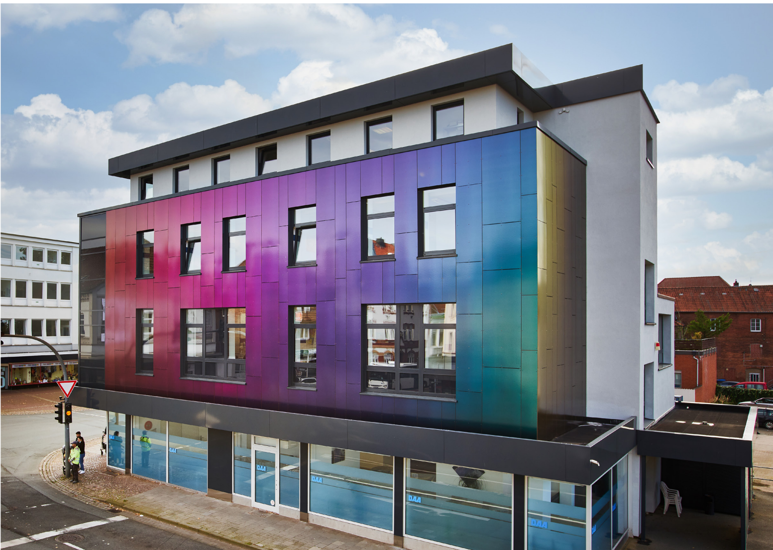
Projekti: Toimistorakennuksen kunnostus, Nienburg, Saksa
