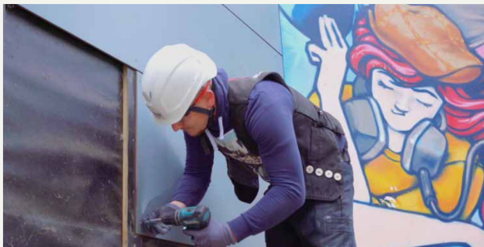
Eenvoudige demontage van panelen van Rockpanel
