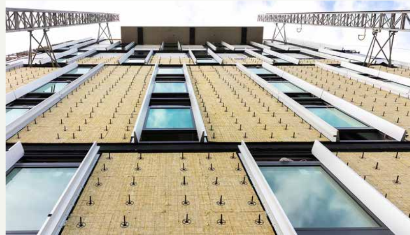
Isolatie van rotswol werkt effectief tegen temperatuur en geluid
