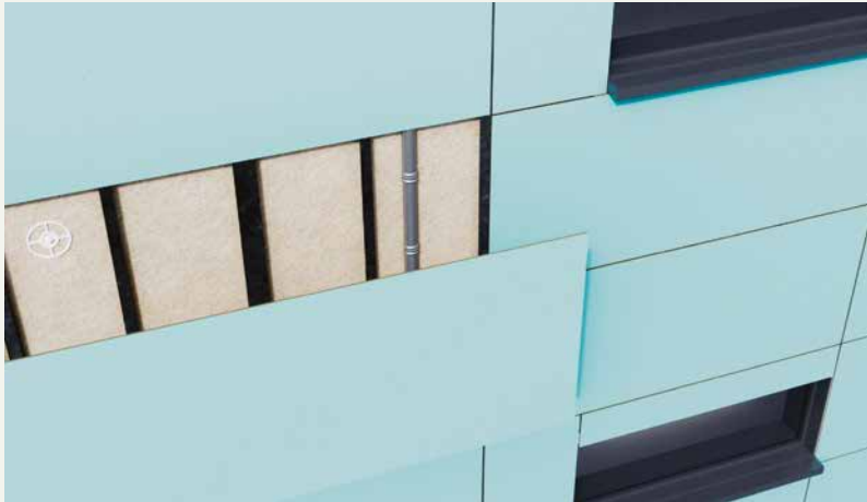
Geventileerde gevelconstructies kunnen afzonderlijk worden gedemonteerd, waardoor ze kunnen worden hergebruikt en/of gerecycleerd
